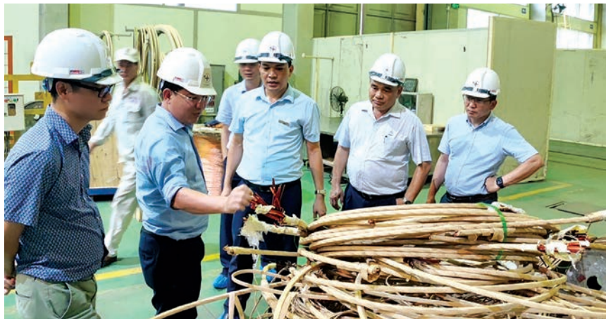
Đoàn công tác kiểm tra trực tiếp công tác sửa chữa máy biến áp tại Tổng Công ty TĐĐ Đông Anh
