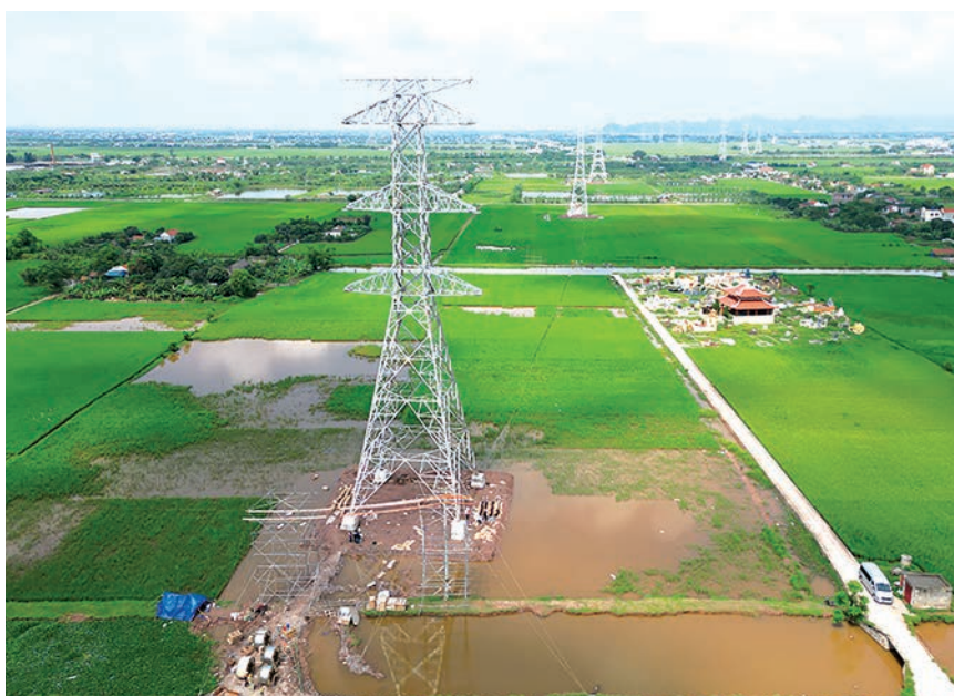
Các đơn vị thi công kéo dây khoảng néo từ vị trí 36 đến vị trí 38 Dự án đường dây 500kV mạch 3 cung đoạn NMNĐ Nam Định I - Thanh Hóa
