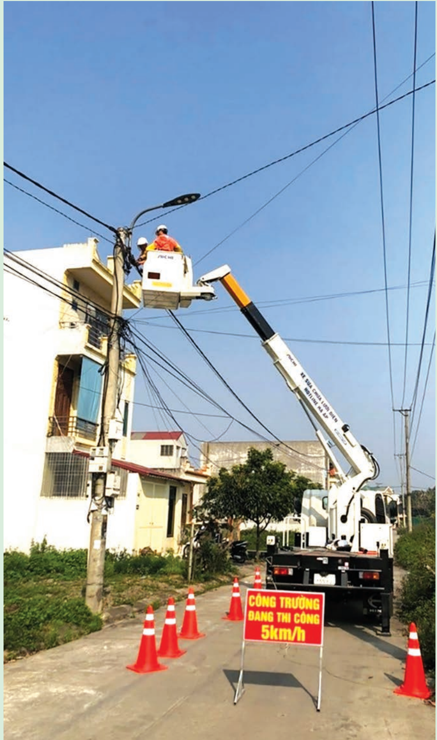
Nhóm công tác Hotline hạ thế đang tiến hành công việc trên lưới điện thành phố Ninh Bình
