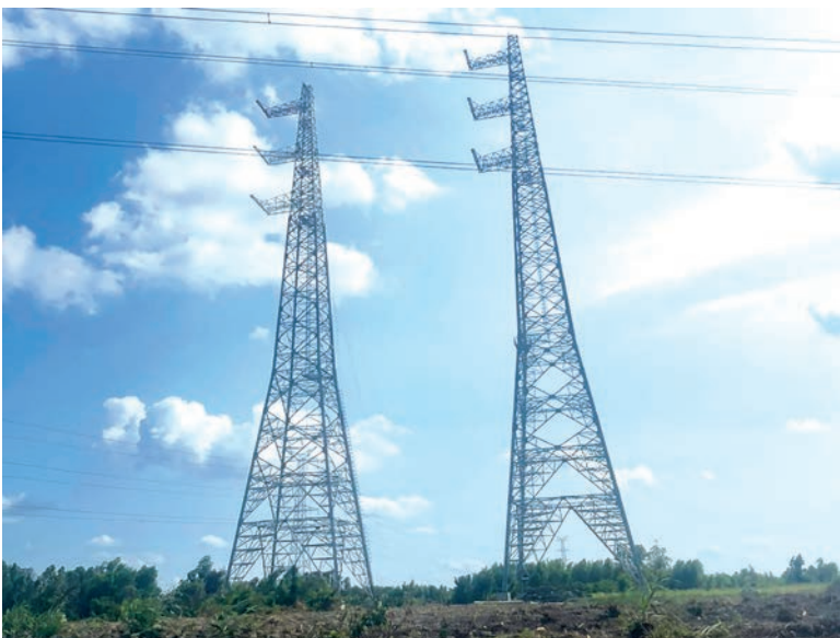
Thi công dự án đường dây truyền tải giải tỏa công suất NMT Nhơn Trạch 3, 4 gặp nhiều vướng mắc về mặt bằng
