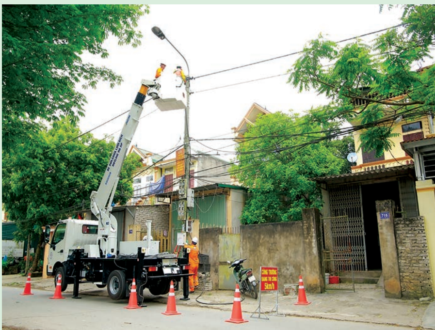
Công tác Hotline hạ thế góp phần đảm bảo các chỉ số tin cậy cung cấp điện cho khách hàng
