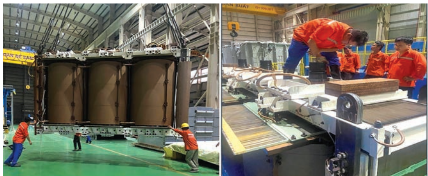
Đẩy nhanh tiến độ sửa chữa kháng tại nhà máy Hanaka
