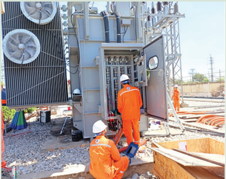
Công nhân PC Hải Dương thực hiện kết nối hệ thống điều khiển xa về Trung tâm điều khiển.
