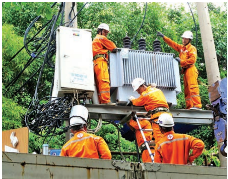
EVNHCMC đảm bảo an toàn điện trong mùa mưa, bão năm 2025
