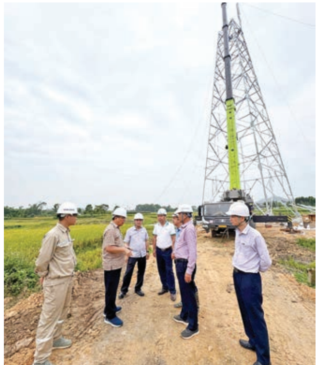
Lãnh đạo EVN kiểm tra thi công dựng cột vị trí VT427
