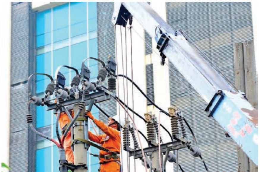
EVNHANOI đã hoàn thành xong nhiều hạng mục nâng cấp lưới điện trung, hạ áp để chuẩn bị cho mùa hè năm 2025
