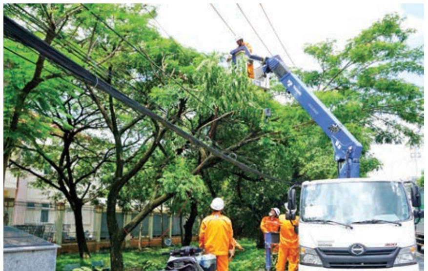
Công nhân ngành điện xử lý nhánh cây để đảm bảo an toàn điện mùa mưa, bão.
