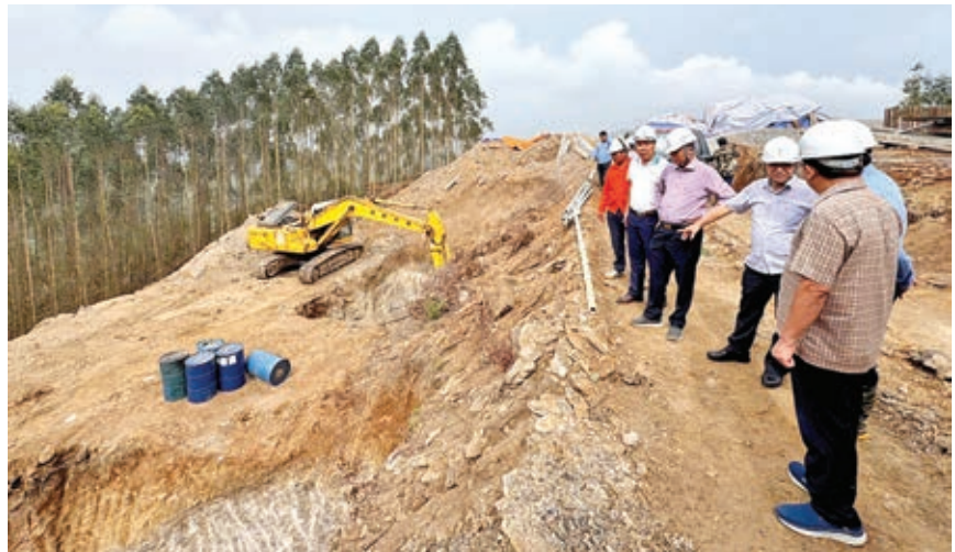
Lãnh đạo EVN kiểm tra thi công tại VT381
