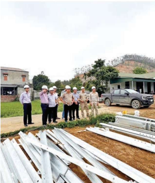
Đoàn công tác kiểm tra tình hình thi công tại vị trí VT461
