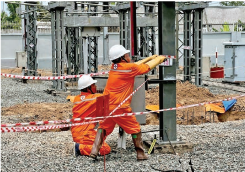
Không quản ngại khó khăn, lực lượng tham gia thi công các dự án đang nỗ lực hết mình nhằm hoàn thành các dự án đúng tiến độ
