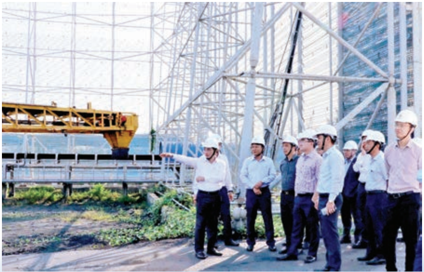
Đoàn công tác EVN kiểm tra công tác chuẩn bị sản xuất điện mùa khô tại Nhà máy Nhiệt điện Vĩnh Tân 2
