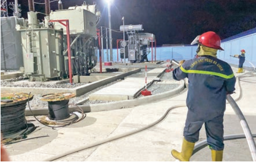
Lực lượng cảnh sát phòng cháy chữa cháy phối hợp với ngành Điện làm việc trong đêm, sẵn sàng đóng điện công trình Lắp máy biến áp T2 Trạm biến áp Khu công nghiệp Du Long (tỉnh Ninh Thuận)
