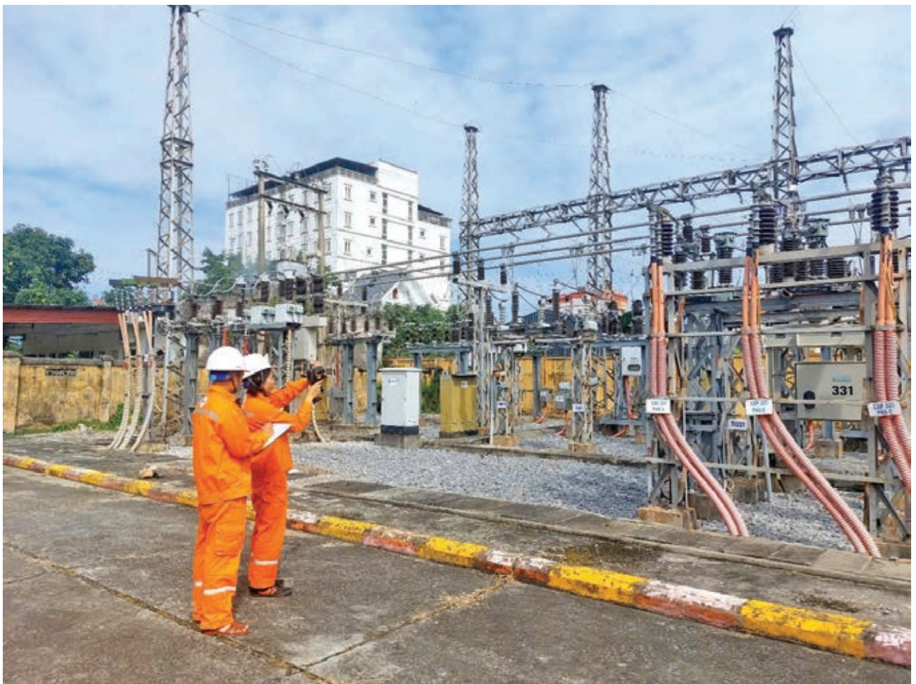
Công nhân PC Hải Dương thực hiện kiểm tra tại các TBA nhằm phát hiện sớm các khiếm khuyết, không để sự cố xảy ra
