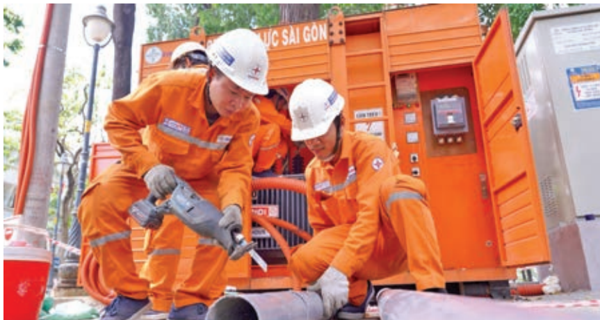
Công ty Điện lực Sài Gòn bảo dưỡng, thay thế thiết bị cũ, lắp đặt thêm tủ điện phân phối hạ thế, máy phát điện diesel công suất lớn
