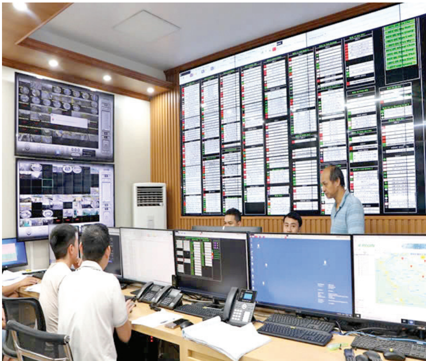
Trung tâm Điều khiển xa tại 27 Công ty Điện lực trực thuộc có nhiệm vụ theo dõi, giám sát tình hình cung cấp điện, điều khiển toàn bộ lưới điện ở các TBA 110KV
