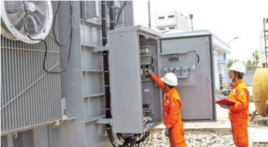
Kiểm tra các hạng mục cuối cùng chuẩn bị đóng điện giai đoạn 1 Dự án Nâng công suất Trạm biến áp 110kV Phước Hòa (tỉnh Vĩnh Long)
