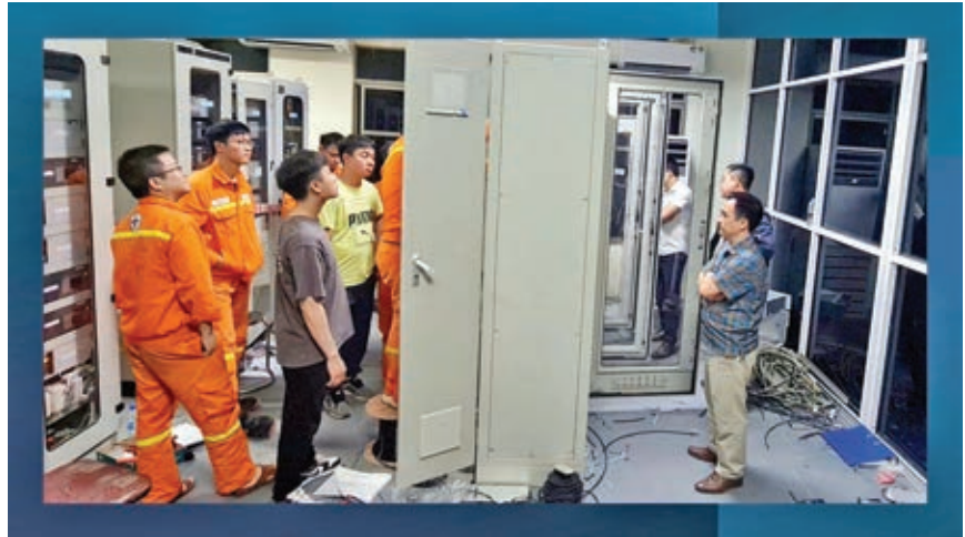
Thi công, thí nghiệm hiệu chỉnh Hệ thống sa thải đặc biệt tại TBA 500kV Nho Quan
