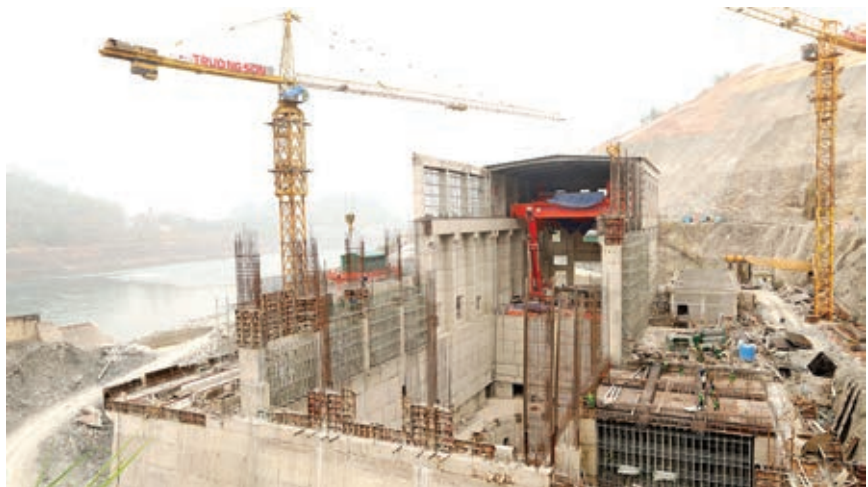
Khu vực thi công Nhà máy Thủy điện Hòa Bình mở rộng
