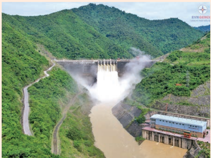
Nhà máy Thủy điện Bản Vẽ điều tiết xả nước qua tràn, cắt giảm lũ cho hạ du trong năm 2024
