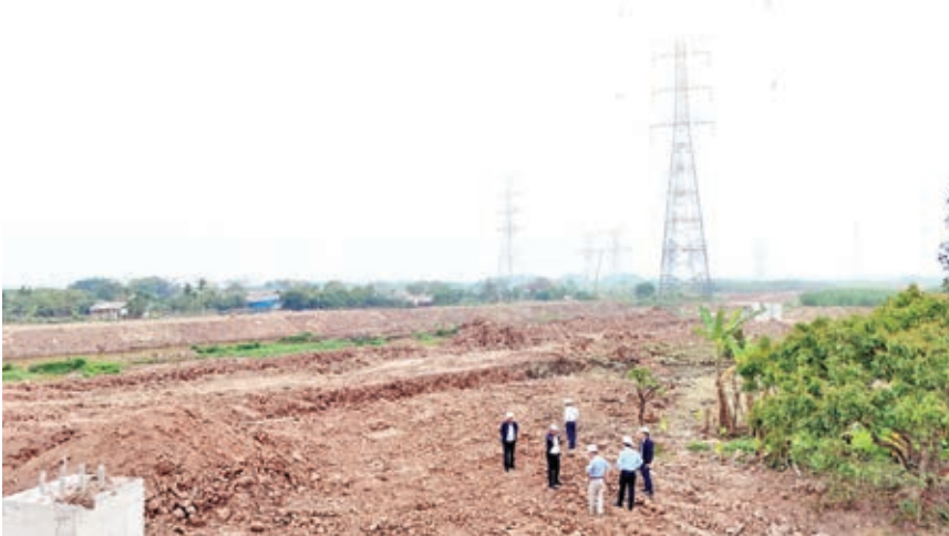
Đoàn công tác kiểm tra điểm giao chéo vành đai 4 với đường dây 500kV, 220kV
