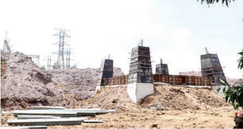
Thi công Dự án đường dây 220kV Sông Mây - Tam Phước
