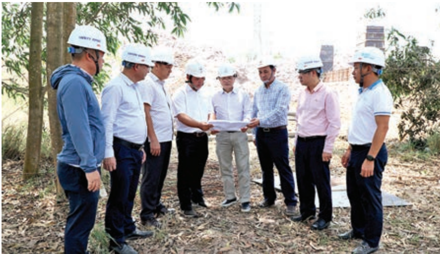
Lãnh đạo Văn phòng Ban Chỉ đạo, lãnh đạo EVNNPT nghe báo cáo tiến độ triển khai Dự án Trạm biến áp 220kV Tam Phước; Dự án đường dây 220kV Sông Mây - Tam Phước
