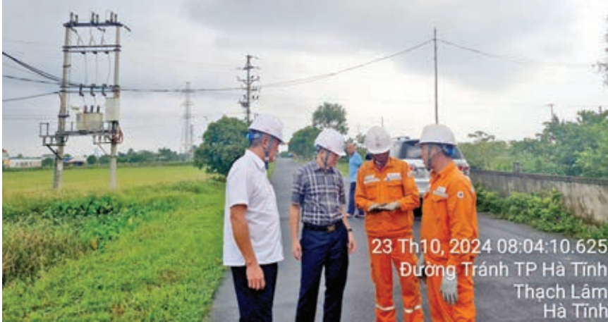
Phó Giám đốc Phạm Việt Thắng và ông Bùi Quang Nhiệm - Trưởng phòng An toàn Công ty trực tiếp kiểm tra, kiểm soát công tác đảm bảo ATLĐ tại hiện trường công tác
