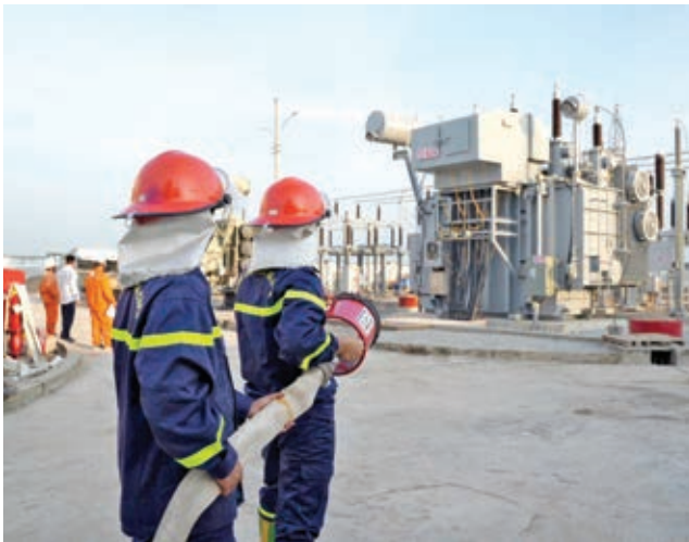
Lực lượng phòng cháy chữa cháy phối hợp chuẩn bị đóng điện máy biến áp T2 Trạm 110kV Tam Nông (tỉnh Đồng Tháp)
