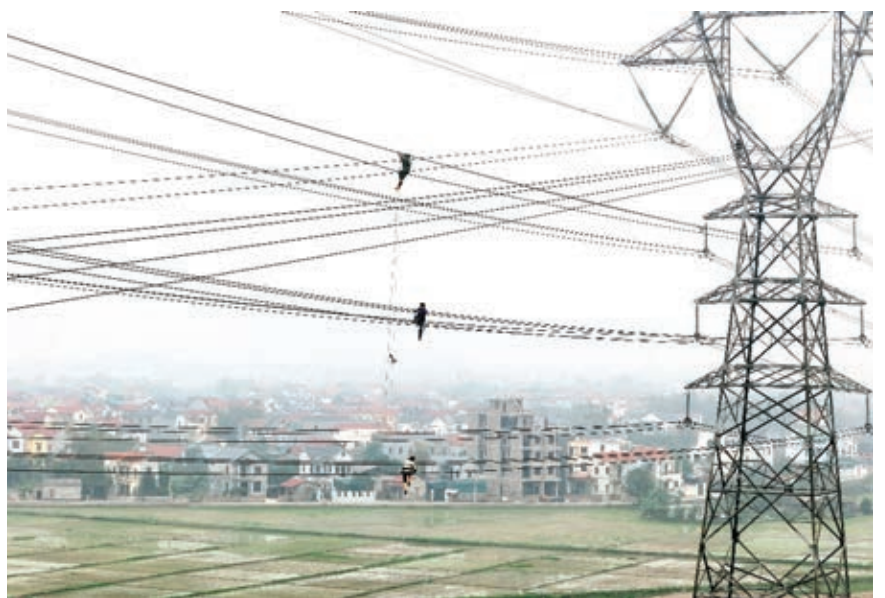
Khoảng cột 70A - 70 đã căng xong 2/3 khối lượng dây dẫn của 01 mạch 500kV và 02 mạch 220kV, thi công đến đâu hoàn thiện lắp khung định vị đến đó
