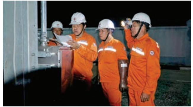
Công tác kiểm tra, nghiệm thu đóng điện kỹ thuật Trạm biến áp 110kV Thanh An, tỉnh Bình Dương
