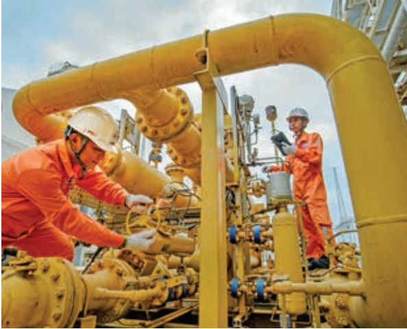
Công tác bảo dưỡng hệ thống tiếp nhận khí NMĐ Phú Mỹ đã được các đơn vị chủ động thực hiện từ đầu năm.
