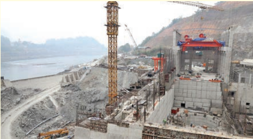
Khu vực thi công Nhà máy Thủy điện Hoà Bình mở rộng
