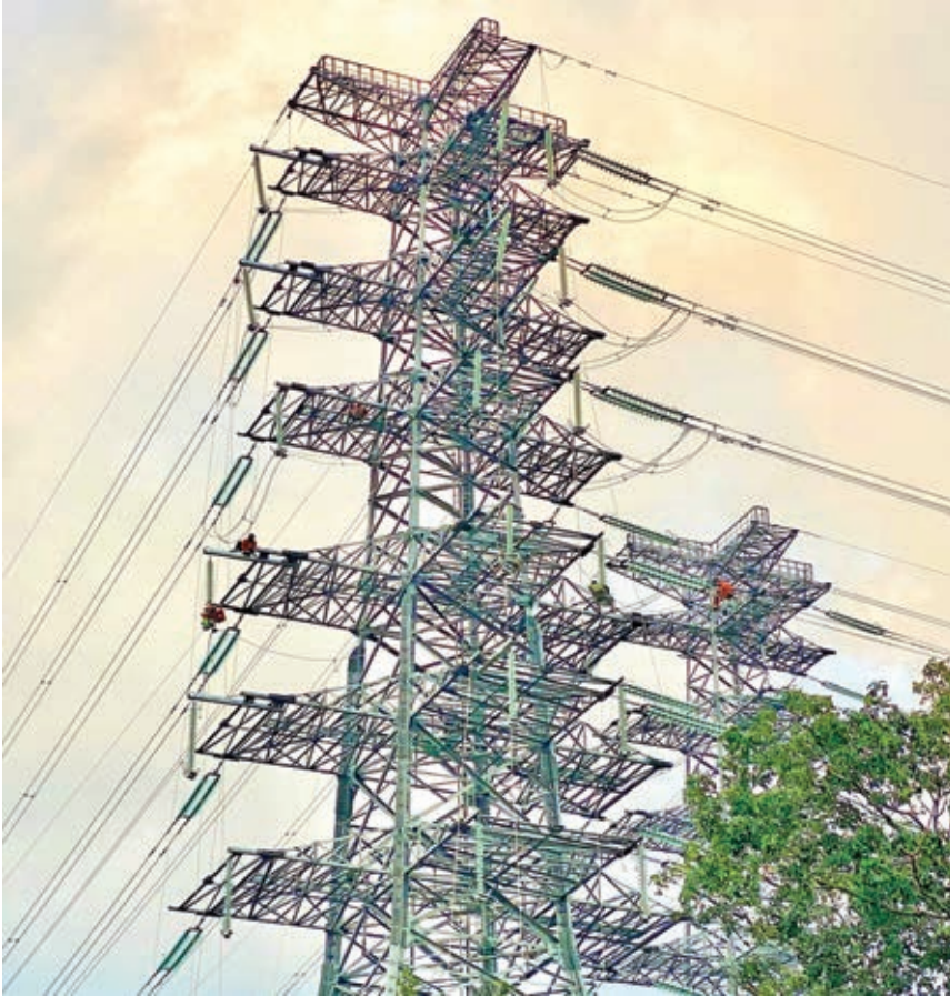
Đoạn tuyến Dự án đường dây 220kV TBA 500kV Long thành - Công nghệ cao đi chung với đường dây 220kV NMĐ Nhơn Trạch 3 - TBA 500kV Long Thành đang được thi công
