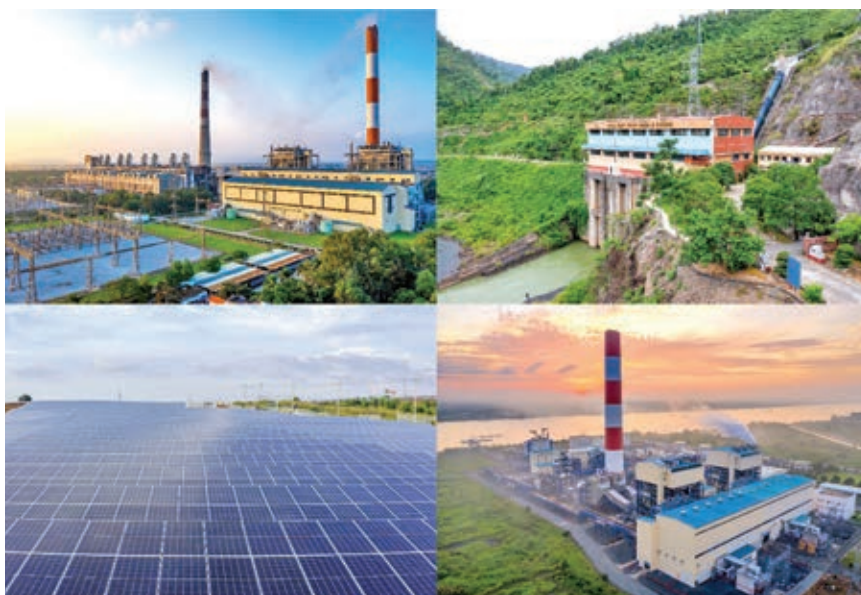
Thủy điện Trung Sơn 3
