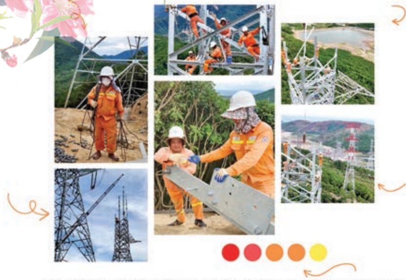
Tại vị trí 08 - Truyền tải điện Hà Tĩnh đang gấp rút hoàn thiện công tác thi công trước ngày 26/8
