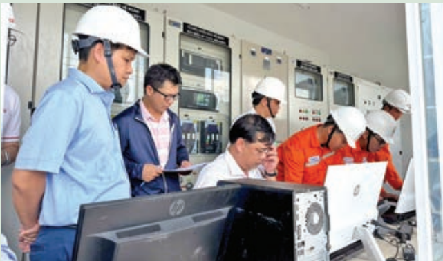
Lãnh đạo EVNSPC giám sát, chỉ đạo công tác đóng điện Dự án TBA 110kV Tân Phú Thạnh (Hậu Giang), ngày 28/12
