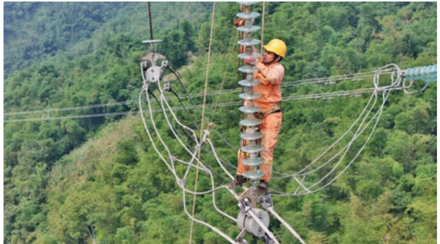
Công nhân PTC1 thực hiện thay sứ đường dây 500kV Mai Châu - Hòa Bình
